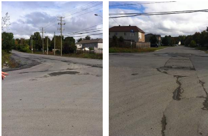
Figures 18 et 19 : Intersection de la rue Front et du chemin Klock
