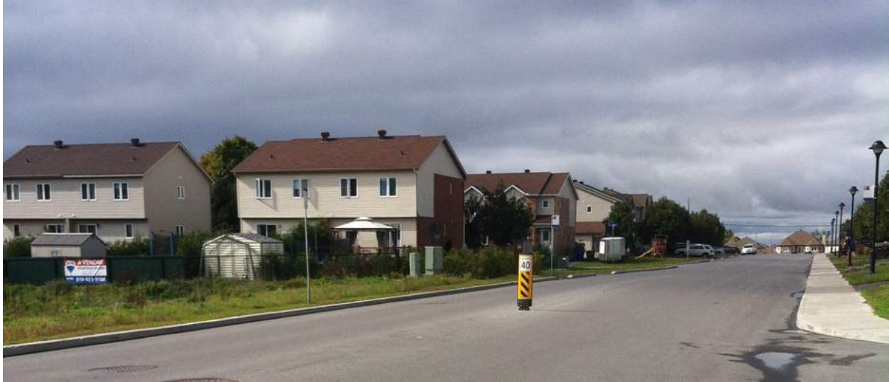
Figure 30 : Bollard sur la rue du Verger à la hauteur de la rue de l'Ours-Noir
