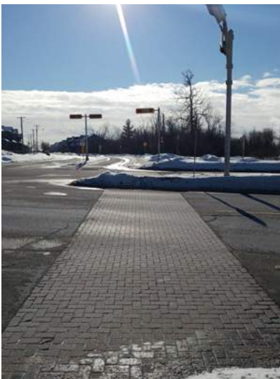
Figure 43 : Terre-plein non entretenu sur la traverse piétonne
