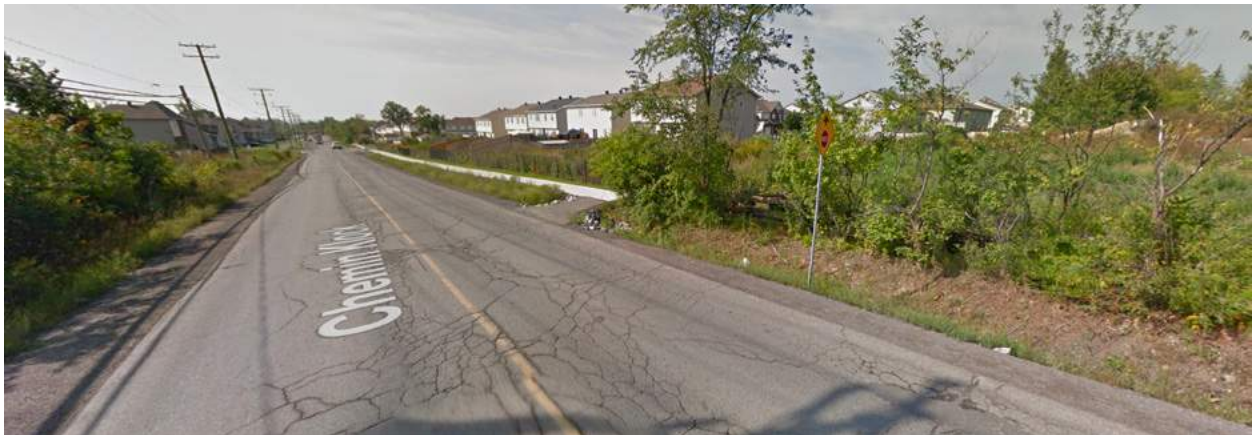
Figure 34 : Trottoir du chemin Klock se terminant abruptement
