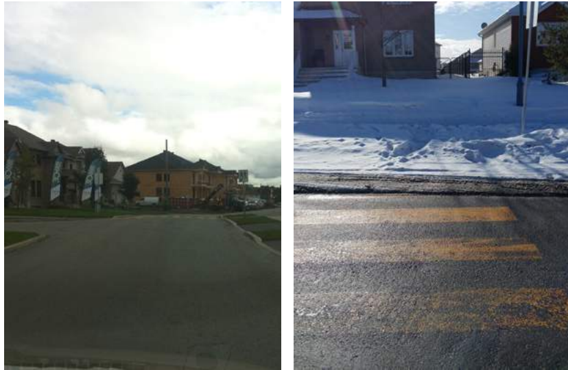
Figures 16 et 17 : Avancée de trottoir de la rue Front et traverse piétonne non entretenue en hiver
