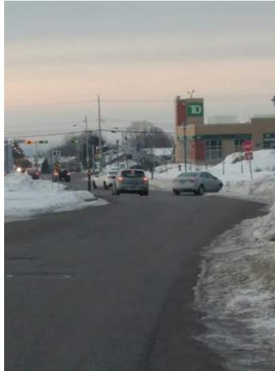
Figure 9 : Absence de marquage délimitant les voies de circulation à l'intersection des rues de la Fabrique et Front
