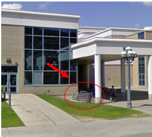
Figure 11 : Supports à vélos avant au 855, de la Gappe
